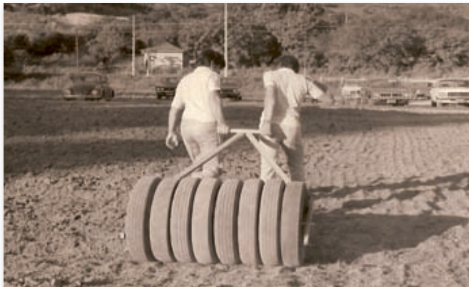
Figura 2. Preparação do terreno para construção do primeiro prédio do CCA. Fonte: Centro de Ciências Agrárias [s.Data]
