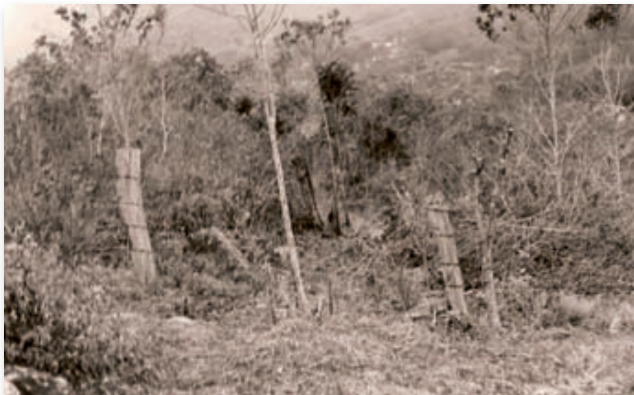
Figura 1. Vista parcial do terreno no Itacorubi onde foi construído o CCA. Fonte: Centro de Ciências Agrárias [s/data]
