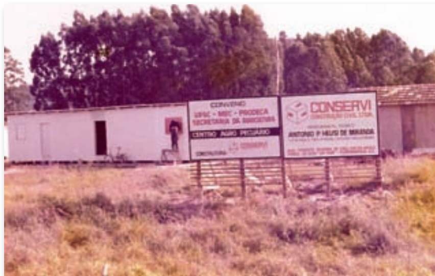
Figura 14. Construção do CCA com auxílio do PRODECA. Fonte: Centro de Ciências Agrárias [s/data]
